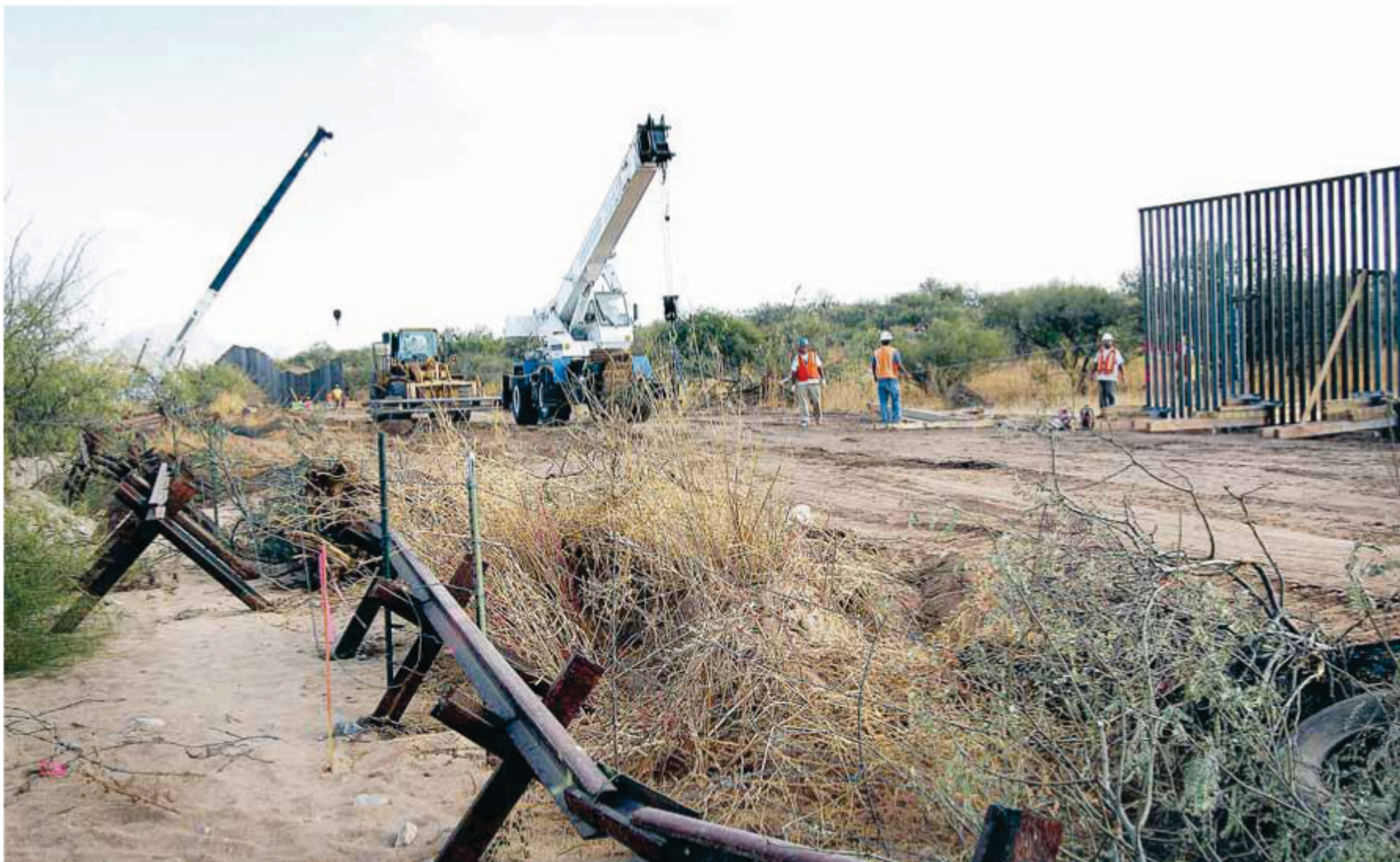
USA:s gränsbarriär mot stora delar av gränsen till Mexiko ska skydda mot illegala immigranter, knarksmugglare och terrorister. Men byggnadsarbetarna som just håller på att färdigställa det här avsnittet utanför den lilla gränsstaden Sasabe i Arizona, rycker bara på axlarna och tror inte att muren kommer att kunna stoppa mer än en och annan kringströvande ko.
